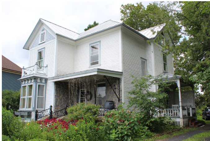
694, rue Shefford. Le plan de cette maison comprend une avancée sur la façade principale et celle de droite, toutes deux couronnée d'un pignon-fronton. Deux galeries protégées ainsi qu'un box-window rythment la composition.
