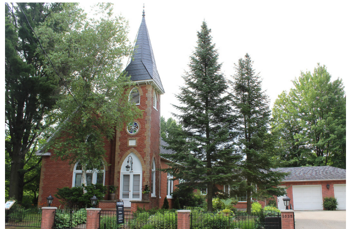
L'ancienne église méthodiste, sise au 1035, rue Shefford, est caractéristique des églises inspirées du style néogothique. Elle est dotée d'une tour-clocher disposée à l'angle du mur pignon qui sert de porche.
