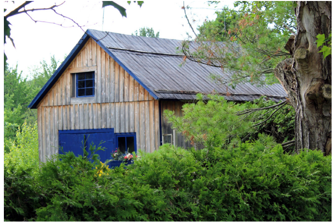
971, rue Shefford. Cette ancienne forge témoigne des nombreux petits commerces du village de West-Shefford qui prennent place dans de petits bâtiments rudimentaires. Elle est très bien conservée.
