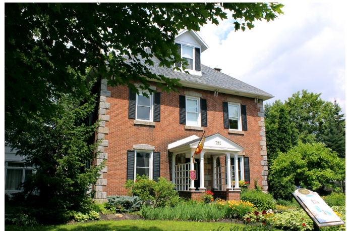
La maison George-Tait, sise au 792, rue Shefford, présente un volume monumental dont la prestance est accentuée par des éléments architecturaux néoclassiques : symétrie, colonnes, fronton et chaînes d'angle en pierre.
