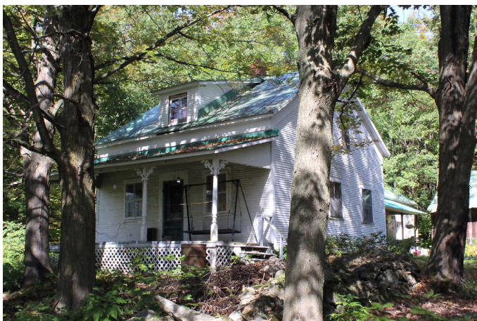
640, chemin Miltimore. Outre les ouvertures disposées en paire dans la partie supérieure du mur pignon, les combles sont éclairés par une lucarne rampante disposée au centre de la façade principale.
