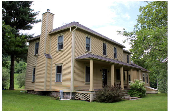
599, chemin du Lac-Gale. Érigée vers 1880, cette maison de ferme possède des fondations en pierre et un parement de planche de bois à clins. Sa composition symétrique est dominée par une large galerie.
