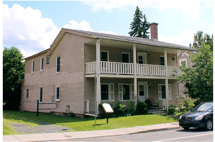
L'ancien hôtel Savage, sis au 883, rue Shefford, s'apparente au cottage georgien avec son imposante volumétrie de forme rectangulaire s'élevant sur deux étages.
