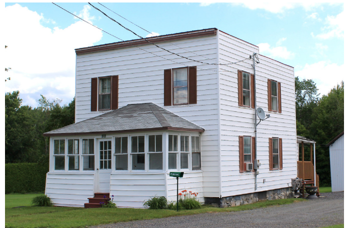
100, rue d'Adamsville. Cette maison présente une composition symétrique. Elle se démarque par sa véranda en façade et ses fondations en pierre. On remarque les gradins sur les côtés, mais la corniche a été simplifiée.
