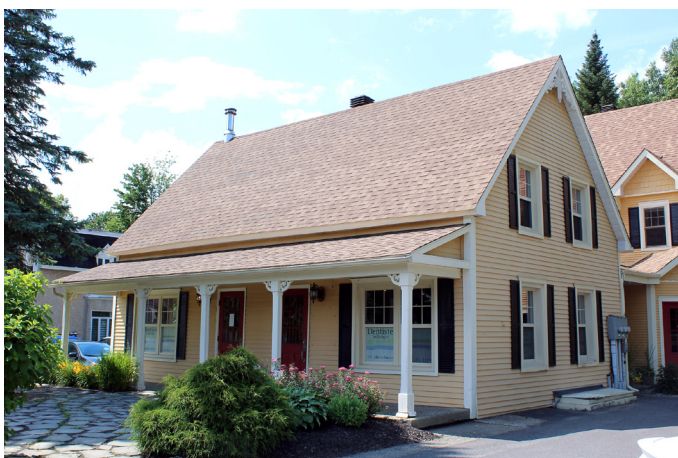
858, rue Shefford. Implanté au coeur de l'ancien noyau villageois de West Shefford, cette maison vernaculaire américaine de type jumelé comportait à l'origine deux unités d'habitation.
