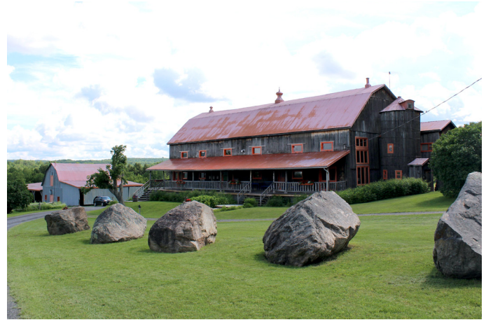
748, boulevard de Bromont. Cette grange-étable se distingue par sa volumétrie imposante, ses façades percées de nombreuses fenêtres et ses vastes galeries. Son silo en bois constitue un élément patrimonial de plus en plus rare.
