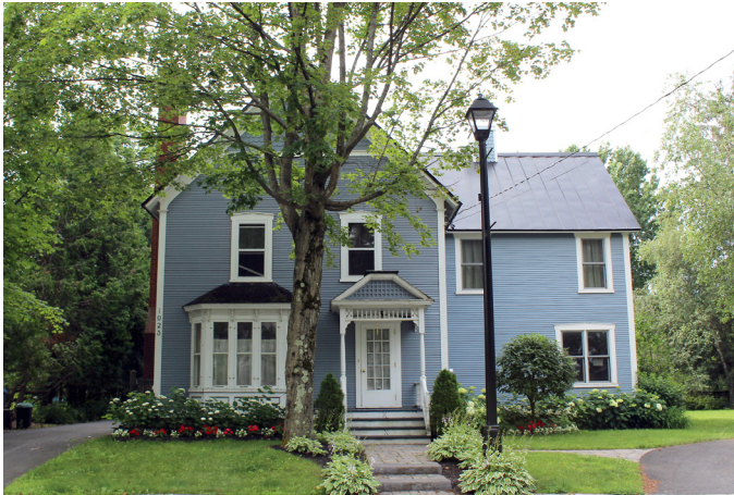
1023, rue Shefford. Bien que d'une certaine simplicité, cette résidence s'apparente au style-néo Queen Anne par ses éléments en saillie (box-window et porche), ainsi que son traitement architecturaux (bardeaux décoratifs, etc.)
