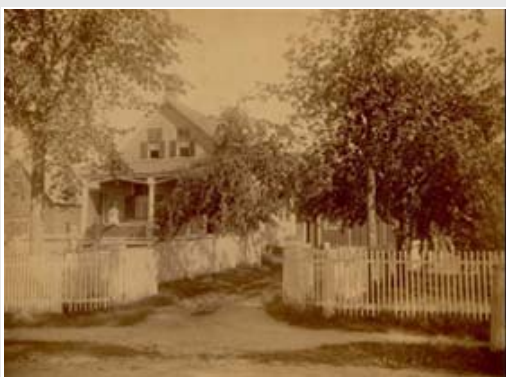
La maison originale avant le surhaussement de 1919
